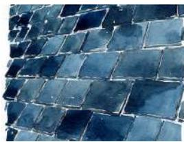
L'ardoise impose une pente minimum.
