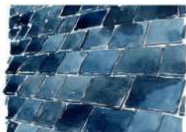
L'ardoise impose une pente minimum.
