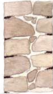
Joints fins affleurant le parement.
