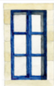
Fenêtre à 2 vantaux, 6 carreaux, en bois peint.
